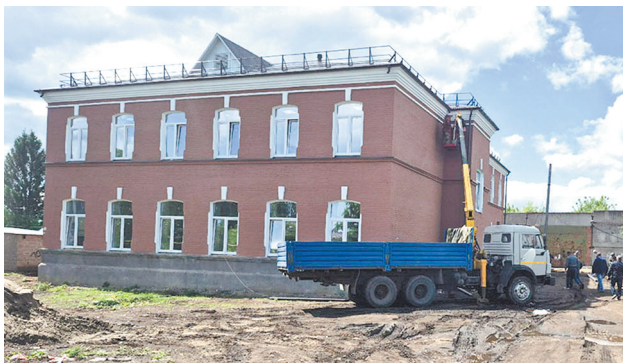
Центр цифровых технологий сельскохозяйственного техникума. Умелые руки строителей привели старинное историческое здание в такое состояние.
