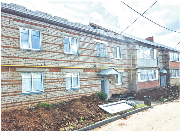
Капитальный ремонт начался в этом доме в поселке Изыскателей.
