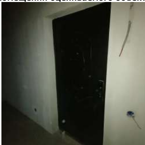
Техническое состояние внутренних помещений оцениваемого объекта
