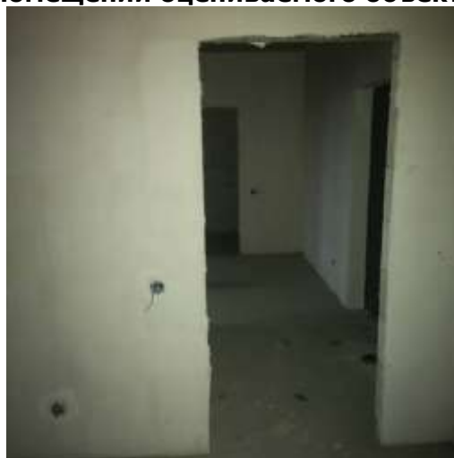
Техническое состояние внутренних помещений оцениваемого объекта
