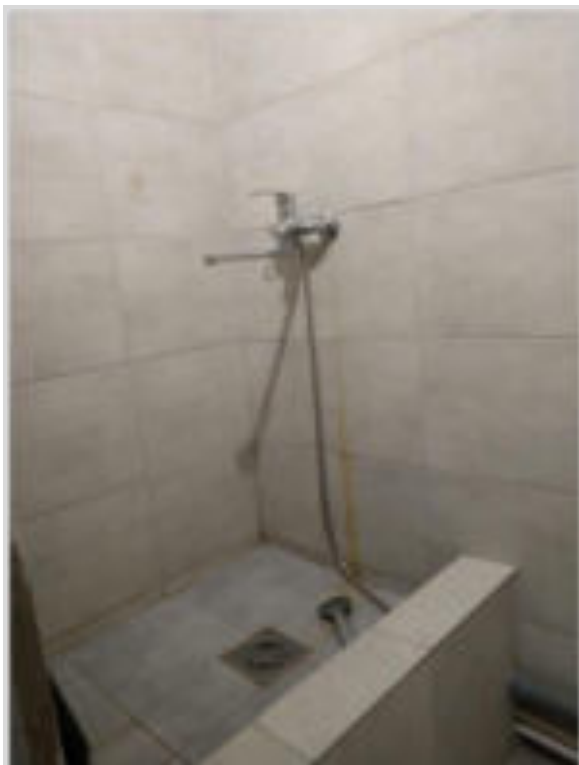
Фото 13. Санузел совмещённый (помещение №3 по плану БТИ)
