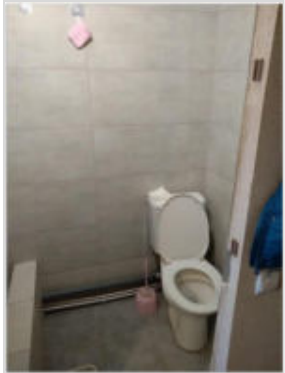
Фото 12. Санузел совмещённый (помещение №3 по плану БТИ)
