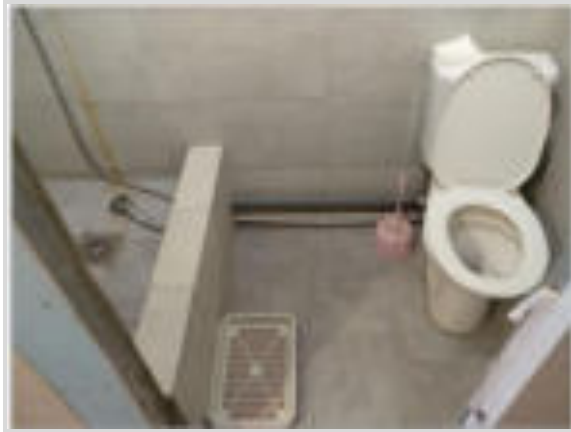
Фото 11. Санузел совмещённый (помещение №3 по плану БТИ)
