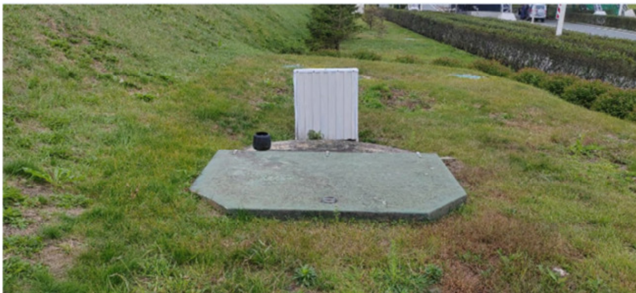
6. Комплектная насосная станция Flo Tenk-KNS-30-47-2
