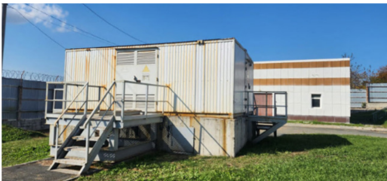
4. Комплектн. трансформаторная подстанция 2 КТП/ТБУ К-К 250/10/0,4 УХЛ 1
